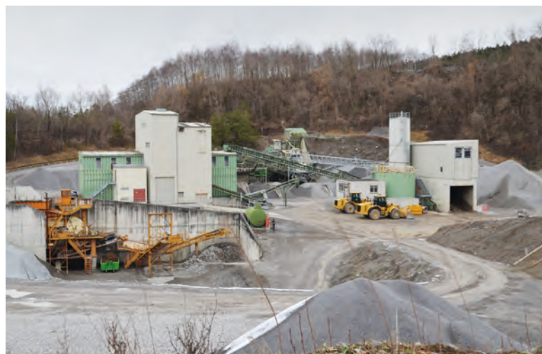
Kieswerk der Firma Ch. Gerster AG
